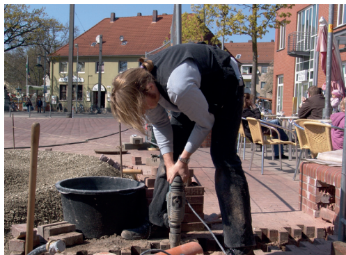
Unterstützung beim Bau des Brunnens am Badenstedter Markt
